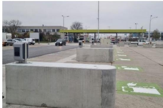
10 SMATRICS-Ladestationen mit einer Ladeleistung von 22 kW zusätzlich ein HPC Charger mit bis zu 300 kW
